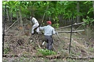
倒木の撤去とネットの補修
